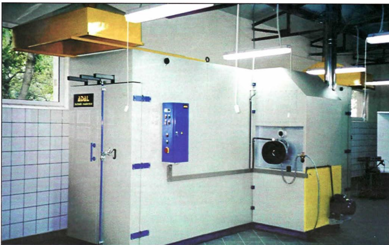
Fot. Piec firmy Adal – zamierzony rozkład temperatur +/-5,3.
